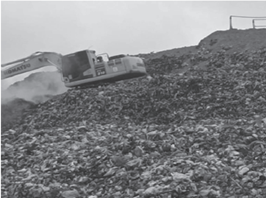
Gambar 4.8 Lahan landfill TPA Gunung Kupang
