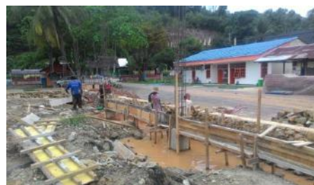
Gambar 7 Pekerjaan Sloof Beton
