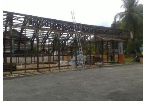
Gambar .1 Pekerjaan Bongkaran Pekerjaan Pengukuran dan Pembersihan Lapangan
