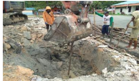
Gambar 6 Pekerjaan Plat pondasi
