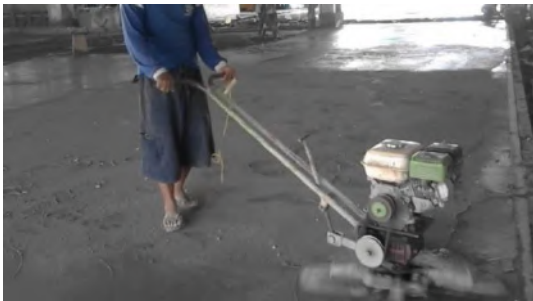
Gambar. 10 Pekerjaan Floor Hardener
