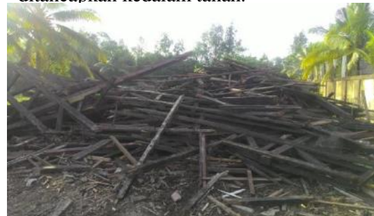
Gambar 2 Pembersihan lahan Pekerjaan Pemasangan Bouwplank
