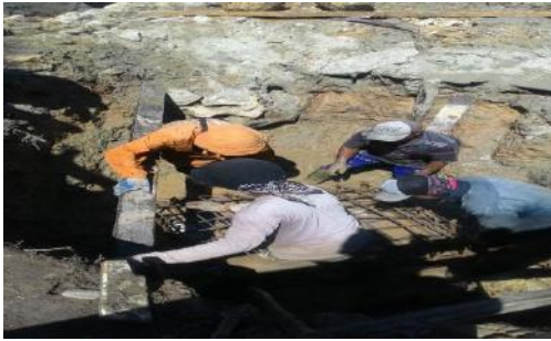
Gambar 4 Pekerjaan Galian Tanah
