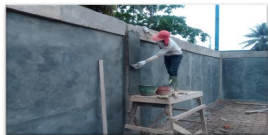
Gambar. 9 Pekerjaan Plasteran dan Acian
