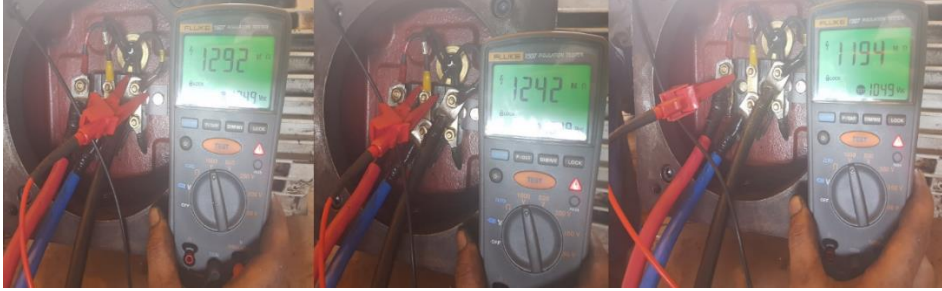
Pengukuran resistansi insulation pada terminal motor BC-03B
