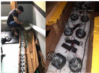
Gambar Perakitan Piezoelektrik Sumber : Dokumen pribadi
