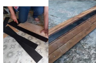
Gambar Proses Pemasangan Karet Selir Sumber : Dokumen Pribadi
